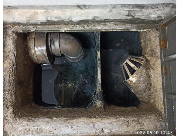
图 2 美容废水消毒池内设过滤网 (TW002)
